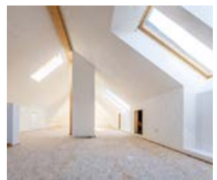
Dachboden Ausbau Attic extension
