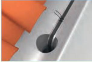
Kantenschutz am Übergang von Dachrinne ins Fallrohr.
